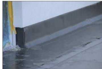
Terrasse am Staffelgeschoss: Anschluss der Flächenabdichtung an aufgehende Bauteile.
