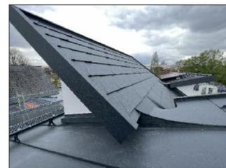
Klempnertechnisch anspruchsvoller Anschluss an der Verschneidung zweier Dachflächen.
