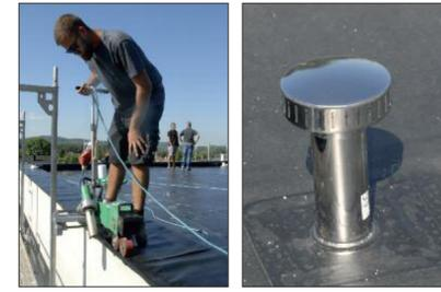
Freie Bahn für die Abluft: Edelstahl-Lüfterelement.
