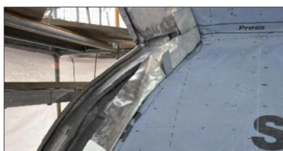
Zur indirekten Befestigung der unterseitig verzinkten Bleischare kommen haltbare Edelstahlhülfe- und -schrauben zum Einsatz.
