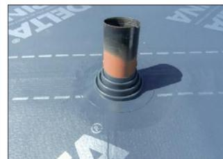
DELTA-ALPINA ausgeführt als Klasse 1 mit DELTA-ALPINA BAND für die Einbindung der Konterlatte.
