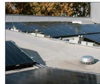
Über das Dach gelangt auch Tageslicht in die Halle – die Abläufe für die Hauptentwässerung sind sauber in die Fläche eingebunden. KWS nutzt das Dach auch zur Energiegewinnung mit PV.
