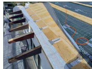
Die energetische Optimierung erforderte von den Dachexperten umfassende Dämmarbeiten, einschließlich der fachgerechten Herstellung einer luftdichten Ebene.
