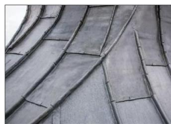
Die vertikalen Längsseiten der Schare auf den Hauben sind durch Hohlwulste verbunden. Die Querverbindungen sind jeweils 10 Zentimeter versetzt, um Materialdoppelungen zu verhindern. Längsfalze der obersten Zwiebel verlaufen entlang der Grate. In der unteren Wölbung folgen sie den Konturen.
